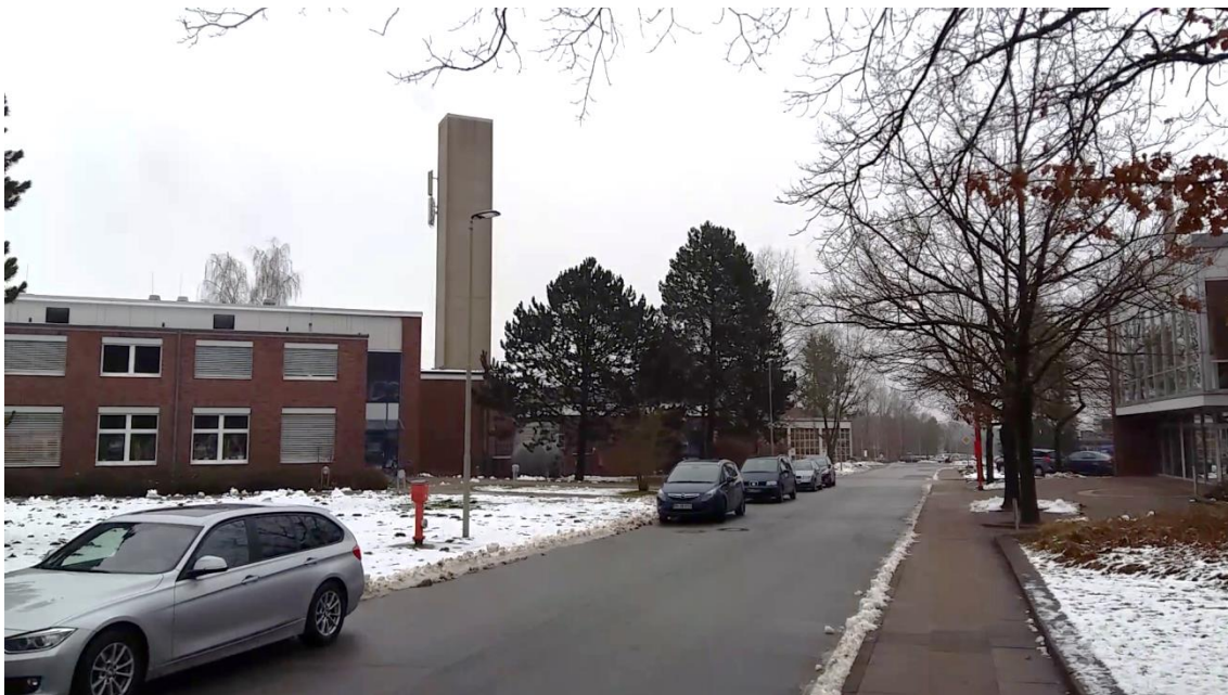
Bild 7: Zentrales Heizgebäude des HZG (Mitte, mit Kamin)
