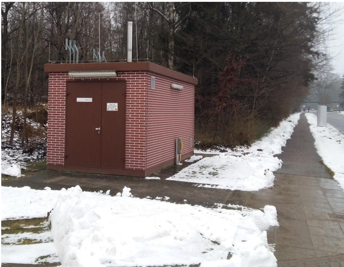
Bild 4: Leitungsverlauf entlang der Max-Planck-Straße vom Eingangsbereich des HZG (Hintergrund rechts) bis zur GDRM-Station der Stadtwerke Geesthacht
