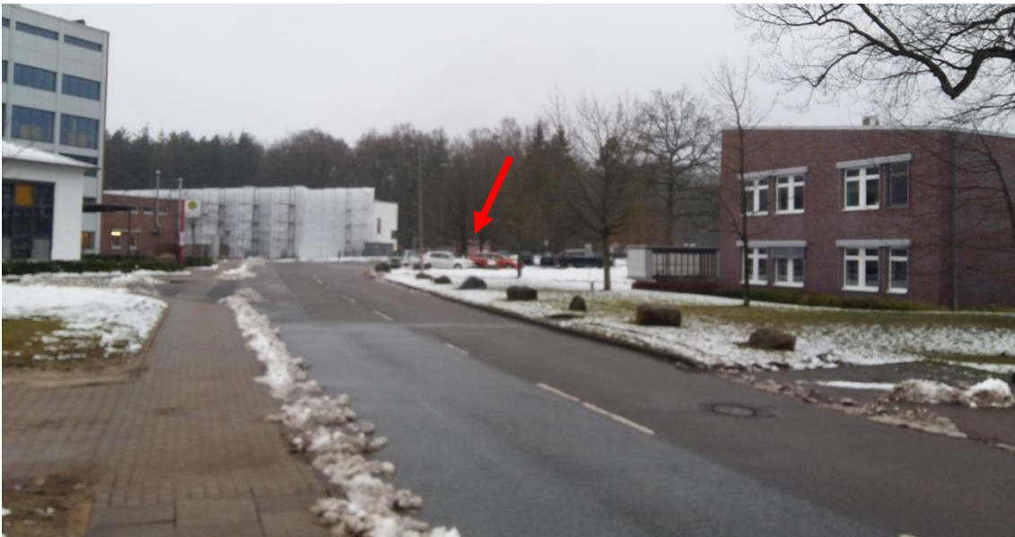
Bild 5: Leitungsverlauf entlang der Max-Planck-Straße von der GDRM-Anlage (roter Pfeil) bis zum Gebäude A des Geesthachter Innovations- und Technologie-Zentrums (GITZ, rechts)
