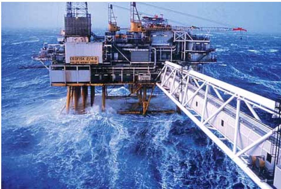
Die Bohrplattform EKOFISK-2 in der stürmischen Nordsee.
