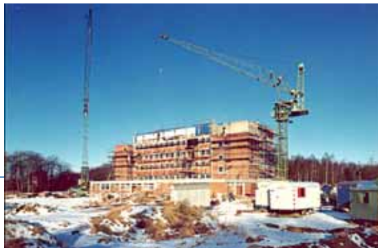
Bau der Geesthachter Unterwasser-Simulationsanlage (GUSI) im Winter 1982/83.
